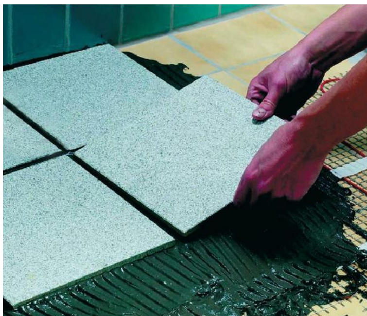
Matę grzewczą umieszcza się w warstwie kleju do montażu terakoty
