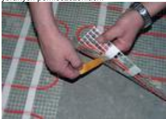
Zastosowanie maty samoprzylepnej umożliwia szybki montaż ogrzewania
