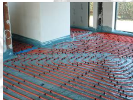
IZOLACJE POSADZEK, RÓWNIEŻ POD OGRZEWANIE PODŁOGOWE.
