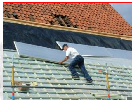
IZOLACJA DACHÓW SKOŚNYCH NAD KONSTRUKCJĄ NOŚNĄ.
