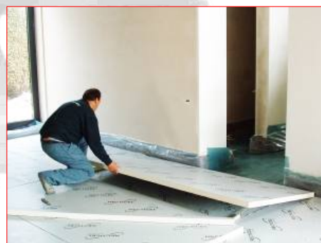
IZOLACJE POSADZEK, RÓWNIEŻ POD OGRZEWANIE PODŁOGOWE.
