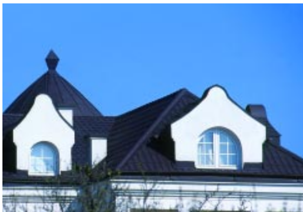
Renowacja dachów produktami Plannja.
