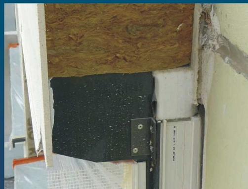
Przykład zastosowania izolacji przy rolcie przykiennej
