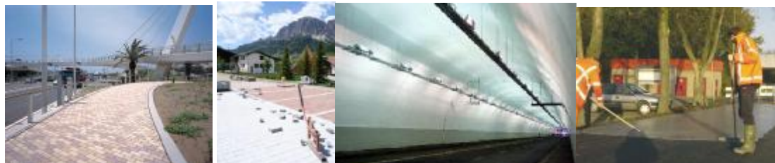
Rysunek 0-9 Od lewej do prawej: chodnik wyłożony kostką NOxer®, kostka brukowa i powłoka w tunelu TX Aria (Italcementi), droga powstała przy wykorzystaniu powłoki KonwéClear (Bouwend Nederland Podium 22, 14.12.2006).
