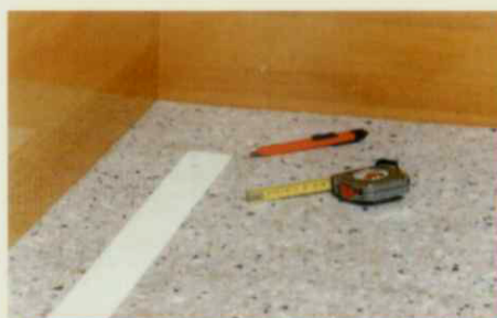
3. Taśma umocowana na ułożonych płytach R – 200
