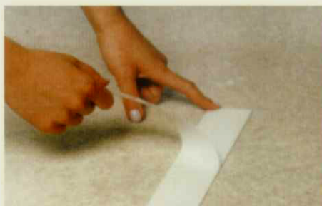
2. Mocowanie płyt R – 200 do podłoża. Taśma łączy krawędzie płyt R – 200
